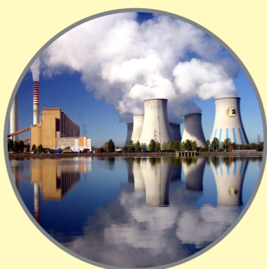
โรงไฟฟ้าพลังงานถ่านหิน (Coal power plant)
